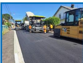
**Les travaux de requalification de la rue du Général de Gaulle se terminent enfin !** Après les travaux d'assainissement, la requalification des trottoirs, c'est à présent à la Communauté d'Agglomération (C.A.E.) de terminer le chantier avec la mise à niveau des regards recouverts par le nouveau tapis d'enrobé mis en œuvre en août dernier par le Conseil Départemental (C.D. 88).
